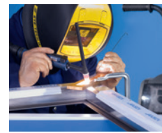
Schweißen Soudage Welding
